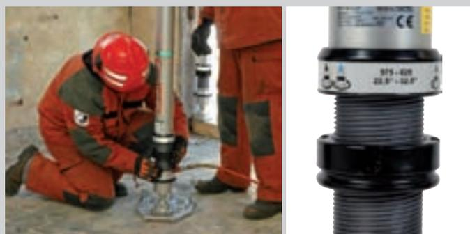
Система с контргайкой устанавливается вручную. Так как она не создаёт никаких дополнительных силовых воздействий, её целесообразно использовать в местах, где воздействия могут вызвать вторичное обрушение, например, в разрушенных зданиях. Контргайка может использоваться на всех типах распорок.
