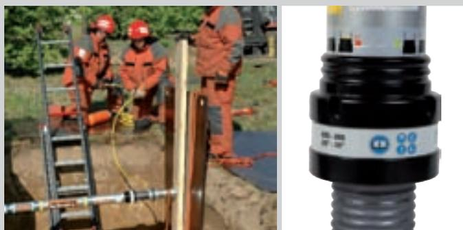
Система с автоматическим фиксатором блокируется автоматически, что позволяет использовать её удалённо: сначала она устанавливается в опасной зоне, а затем раздвигается из безопасного места при помощи пневматического или гидравлического привода. Только пневматические и гидравлические распорки могут быть оборудованы автоматическим фиксатором.
