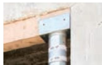
Балочные упоры используются вместе с брусом при закреплении обрушенных зданий.
