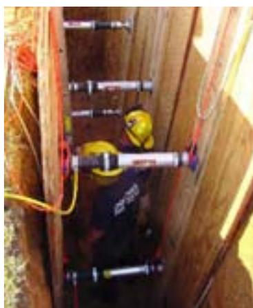
Закрепление провала пневматической распоркой с фиксатором.
