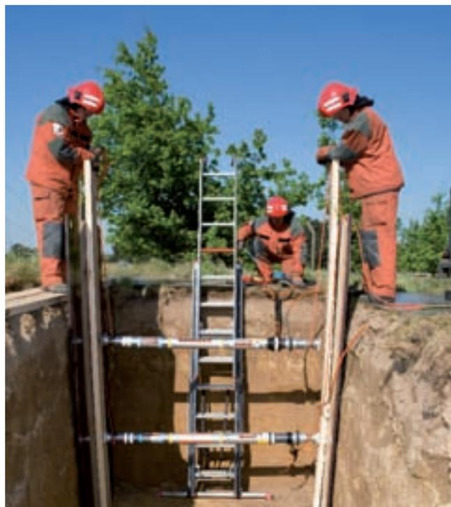
Дистанционное закрепление гидравлическими распорками с автоматическим фиксатором.
