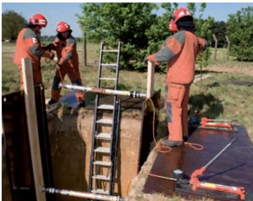
Удалённое крепление при помощи гидравлических распорок с автоматическим фиксатором.
