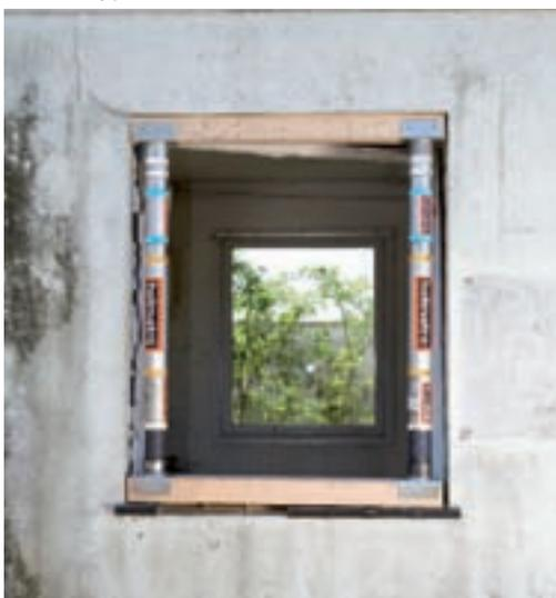
*Ручные распорки с удлинителями, балочными упорами и балкой, установленные для стабилизации окна.*
